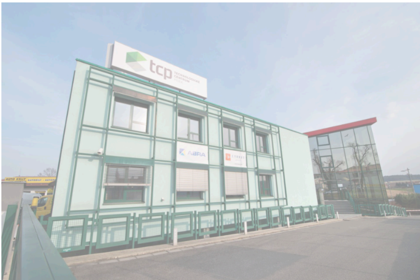
Technology Center Písek Pražská 483, 397 01 Písek
