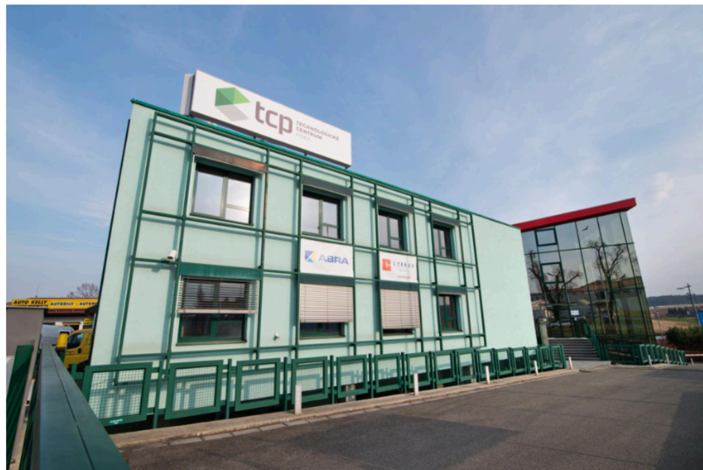
Technology Center Písek Pražská 483, 397 01 Písek
